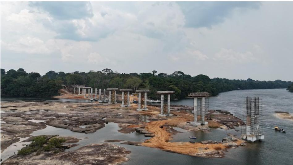
No momento, são concretadas as colunas que dão suporte à ponte, trabalho que está mais avançado no lado de Cotriguaçu. No trecho que vai ser asfaltado, o Governo realiza a terraplanagem e a construção da sub-base da pista.
