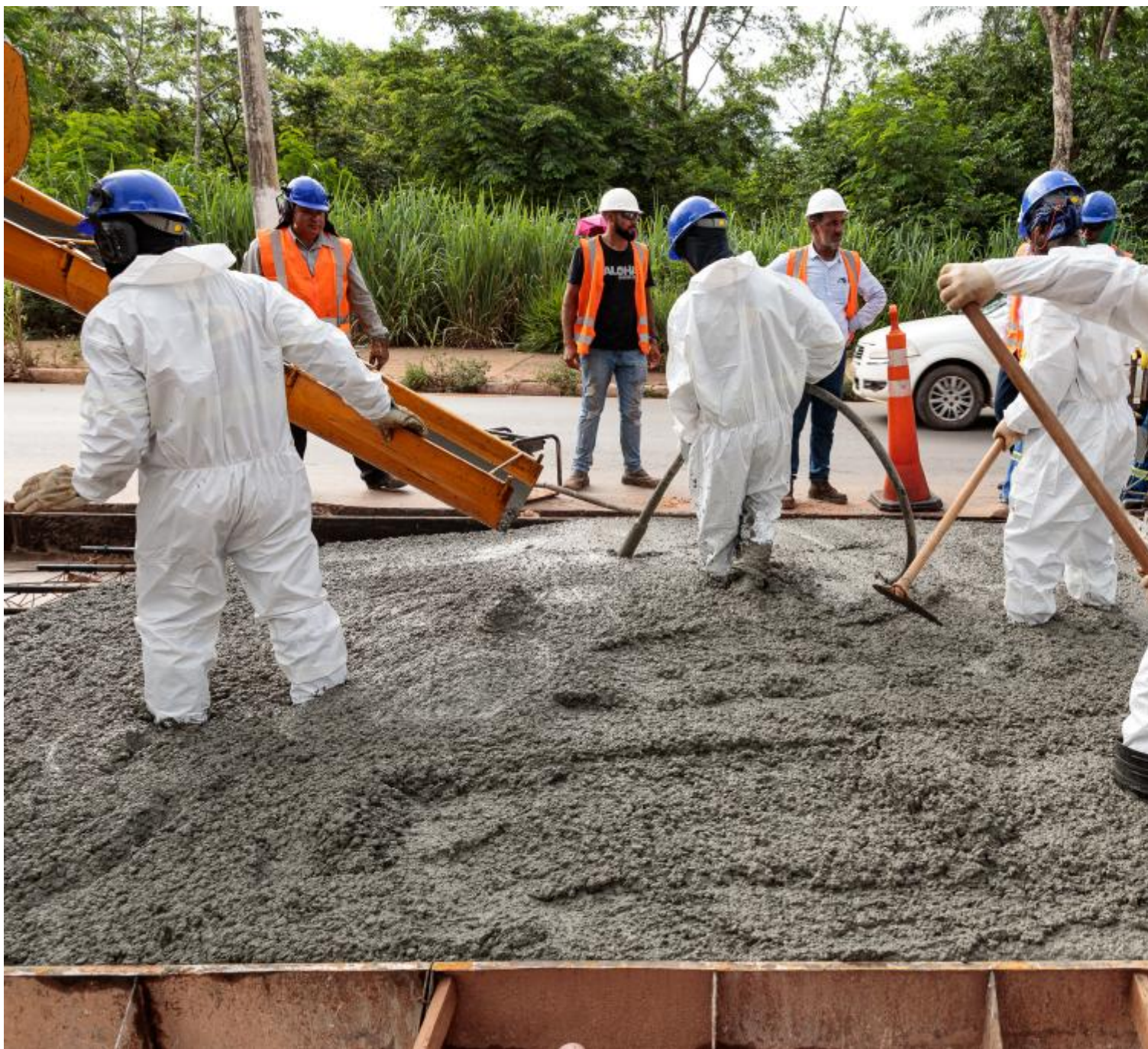
Obras do BRT Av. CPA Concretagem Créditos: Marcos Vergueiro/Secom-MT
