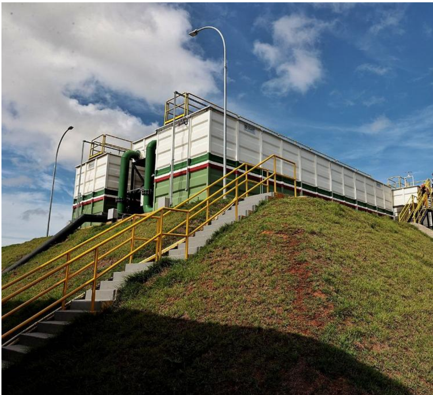
Inauguração da ETA Barra do Pari em Várzea Grande Créditos: Mayke Toscano/Secom-MT
