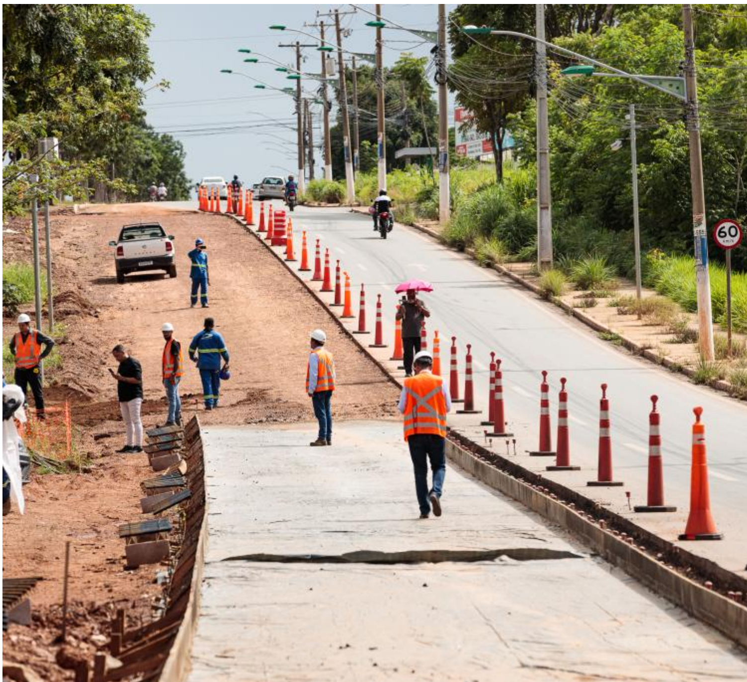
Obras de concretagem das pistas do Sistema BRT na Avenida do CPA Créditos: Marcos Vergueiro/Secom-MT
