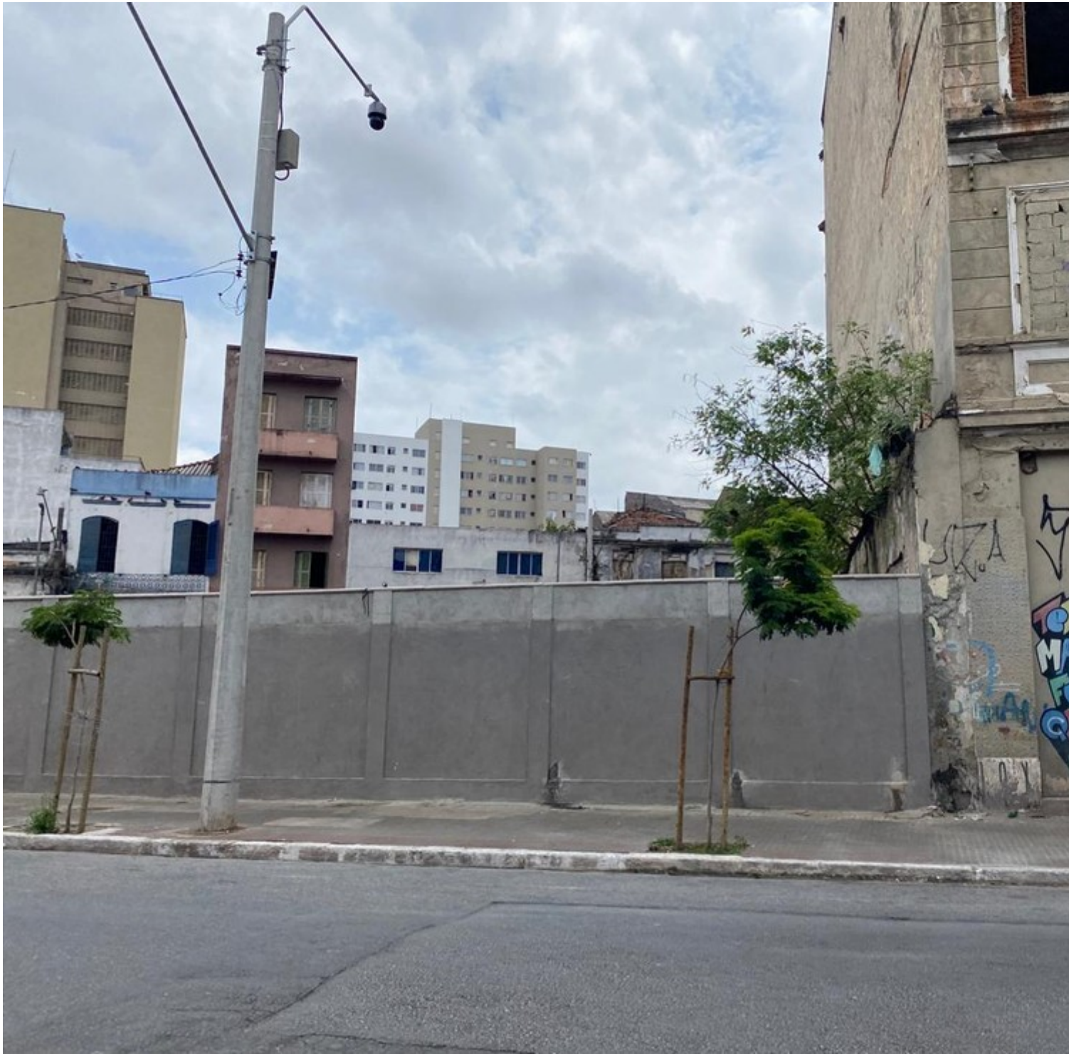
Muro na Cracolândia — Foto: Deslange Paiva/g1
