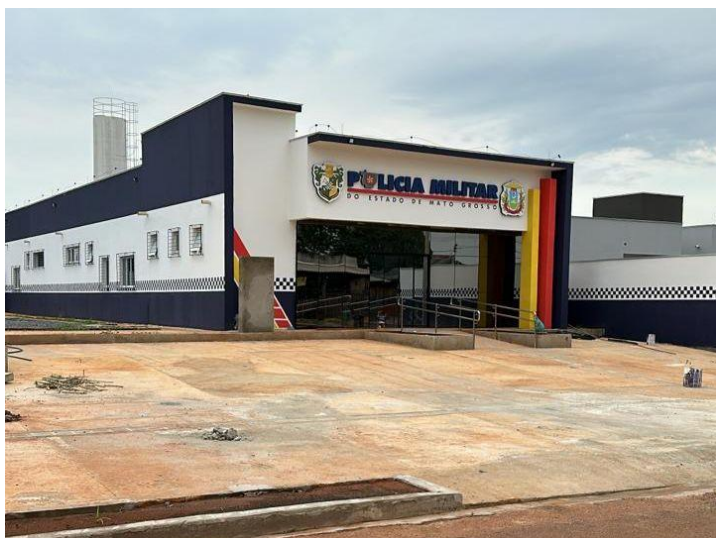
Em União do Sul, o novo NPM é ao lado da vila residencial militar
