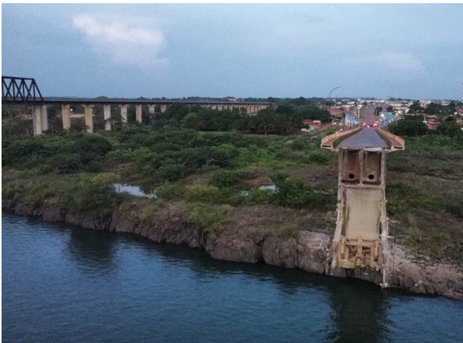
Ponte Juscelino Kubitschek de Oliveira após desabamento — Foto: Francisco Sirianno/Grupo Mirante
